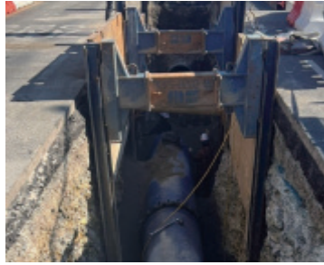
[흙막이 지보공 설치]
