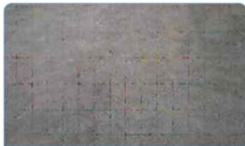
개선 후 - 콘크리트 바닥 공사
