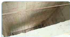
엘리베이터 개구부 안전난간 미설치
