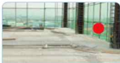
슬라브 단부 안전난간 미설치
