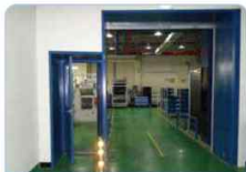
보행자용 출입구 설치
