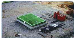
개구부 덮개 설치
