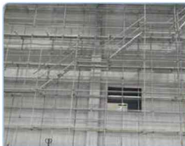
안전난간 설치
