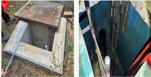
〈지하 진입통로(지상)〉 〈사고발생 물탱크(지하) 입구〉
