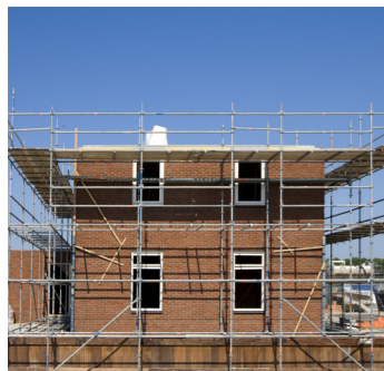
강관 비계(Steel Pipe Scaffold)
