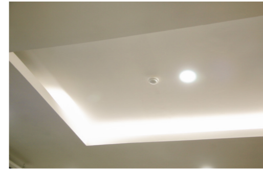
우물천장 설치 예시
