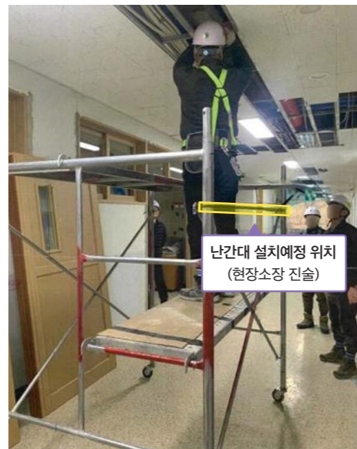
설치했어야 하는 안전난간 위치
