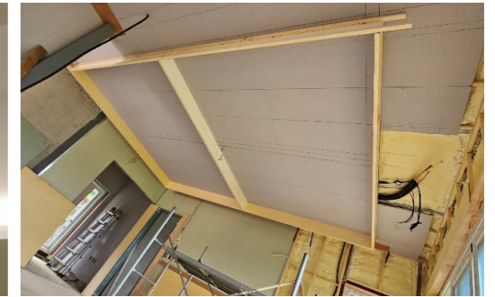
재해 당시 우물천장 시공
