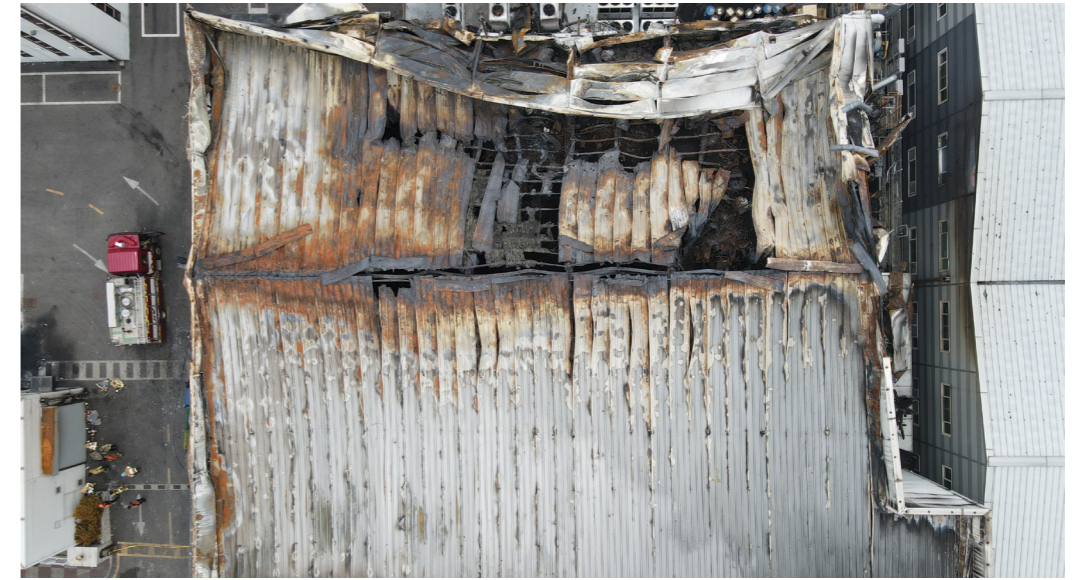
AA건전지 크기만한 리튬 1차 전지 한 개의 폭발로 시작된 불길의 공장 한 동 전체를 태웠다
