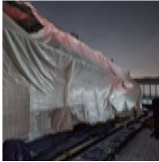
[콘크리트 보온양생 장소]
