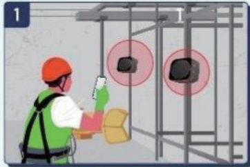
1 양생작업 전 양생공간 내부에 일산화탄소 감지기 설치 (면적을 고려하여 양생작업 내부에 최소 2대이상 설치)
