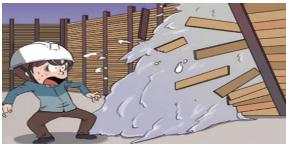
지반 연약화로 인한 흙막이 지보공 무너짐
