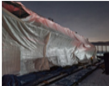
[콘크리트 보온양생 장소]
