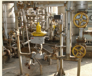
공기구동형 조절 밸브가 설치된 모습
