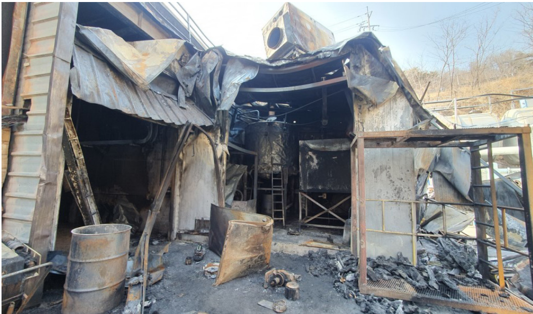
화재 진압 후 여과실 전경
