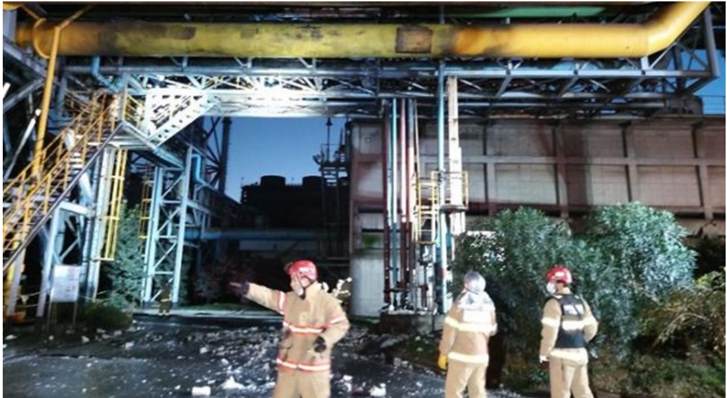
사고 직후 소화 완료된 현장
