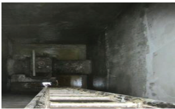
[ 지하 공동구 박스 내부 ]
