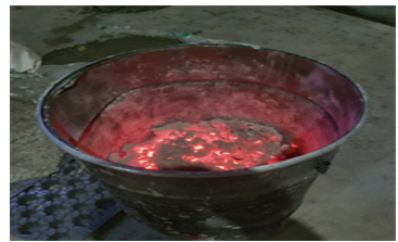
[ 갈탄 콘크리트 양생 장소 ]
