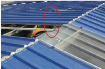
[ 창고 지붕(패널) 仓库屋顶(钢瓦) ]
