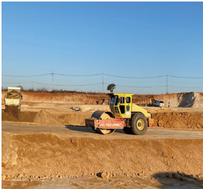
다짐 压实作业
