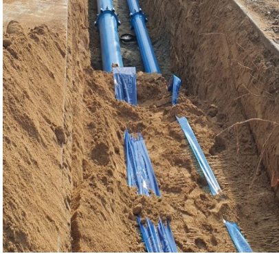
관로매설 후 되메우기 管道施工完进行回填
