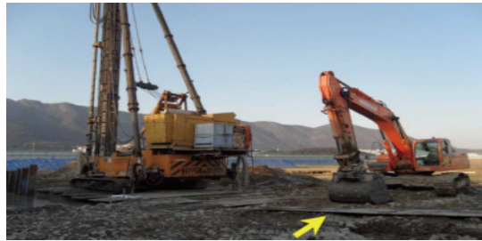
[ 항타기(흠막이 파일 박기) 打桩机(进行挡土板安装) ]
