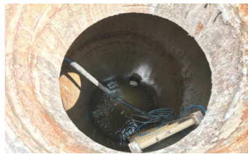
[맨홀 내부 窨井内部]
