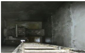
[지하 공동구 박스 내부 地下通道箱体]
