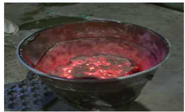
[갈탄 콘크리트 양생 장소 褐煤混凝土养护地点]
