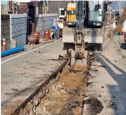
굴착 작업 挖掘作业
