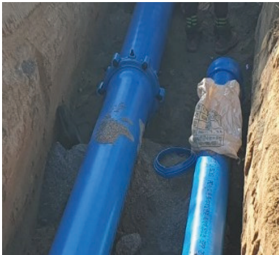
관로 매설 管道埋设
