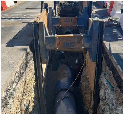
흙막이 설치 安装挡泥板
