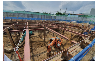
[ 흠막이 가시설(버팀보) 挡土墙临时支撑(支撑梁) ]
