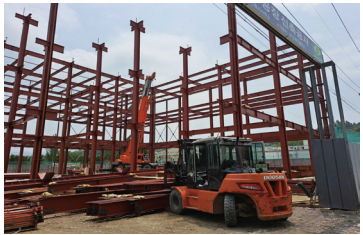
[ 철골 기둥 및 보 钢柱和梁 ]
