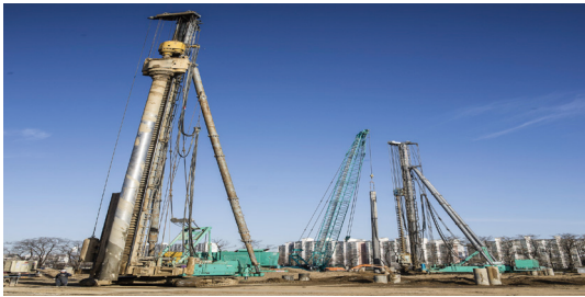
[ 항타기(말뚝 박기) 打桩机(打桩) ]
