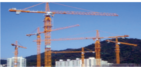
[ T-형 타워크레인 T型塔吊 ]
