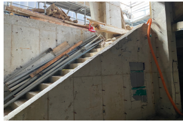
[계단 측면 단부 楼梯侧端部]
