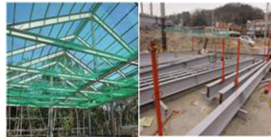
추락방호망 · 안전대걸이시설 설치
