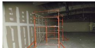
상부작업대 안전난간 설치
