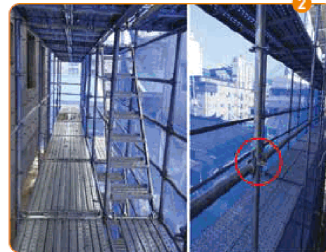
추락방지용 작업발판이 설치된 시스템비계의 모습
