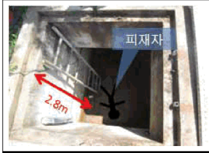
하수처리시설 폐쇄 건적조사 중 산소결핍에 의한 질식
