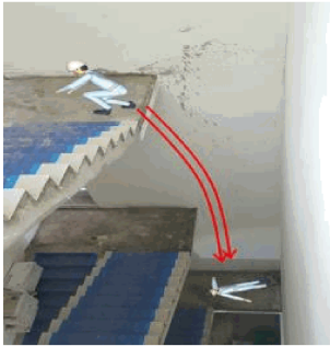
계단참 바닥 몰탈타설로 안전난간을 철거 후 작업
