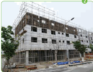
'추락위험장소'에 작업발판이 설치되지 않은 모습
