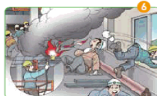
건물내부 철거작업 중 용단 붕괴로 화재
