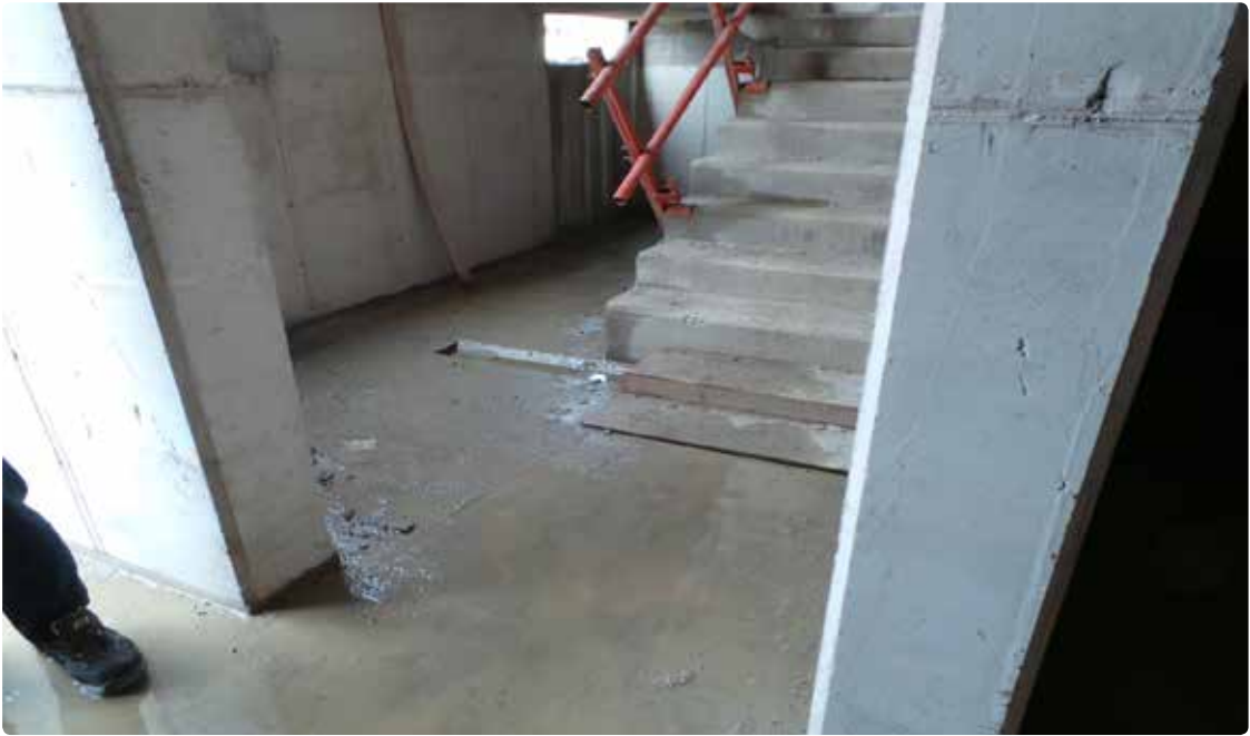
[사진1] 재해자가 최초 목격된 지하1층 계단실
