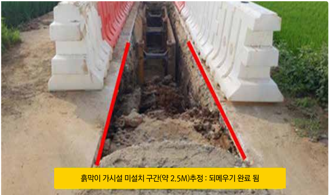
[사진2] 재해발생 공사 구간(공사구간 No.26)
