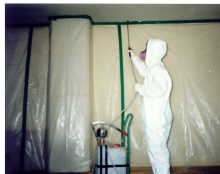
<그림 5> Encapsulant분사
