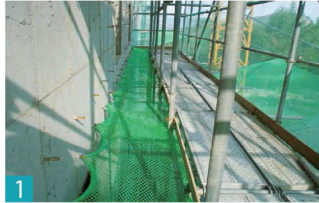
1 강관비계 설치 사례
