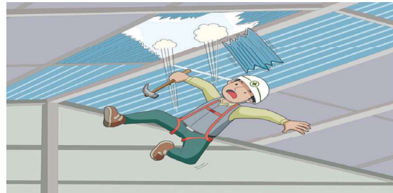
지붕 개·보수 및 태양광 공사 중 떨어짐
