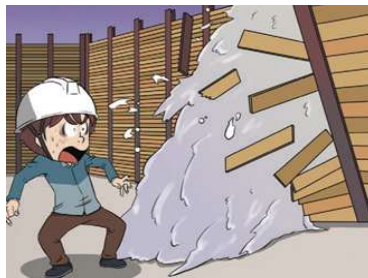
지반 연약화로 인한 흙막이 지보공 무너짐
