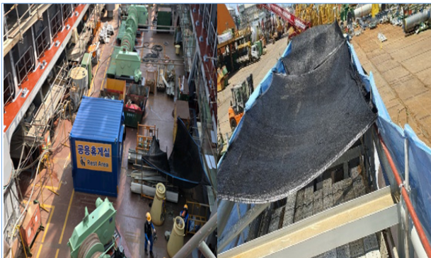
건조선박 작업장소 휴게시설·그늘막 설치
