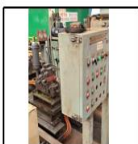
크레인 조작 지보한 정위치 장소 설치 (대원D)
