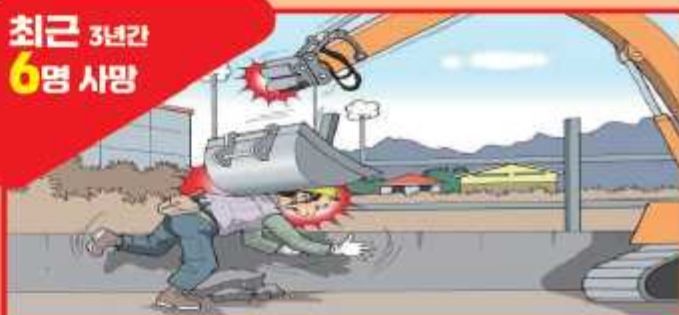
굴착기 작업 중 버킷 탈락
