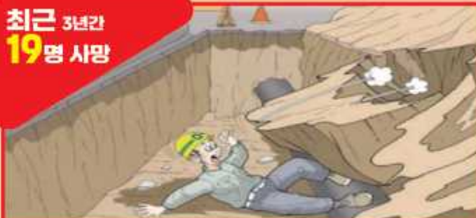
관로 공사 중 매몰
