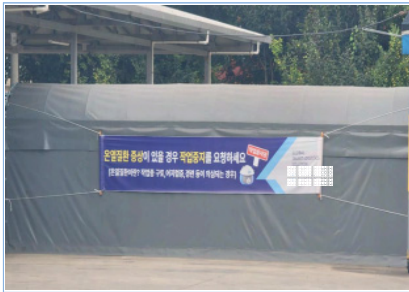
작업중지권 보장 현수막 설치
