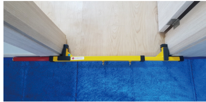
② 안전바 설치(문틀 쪽에 맞게 길이 조절 후 고정)
