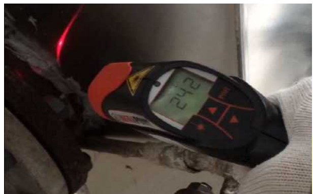
그림-6. 스팀 배관 온도측정 (사고복구 후 정상운전 시 측정 자료임)
