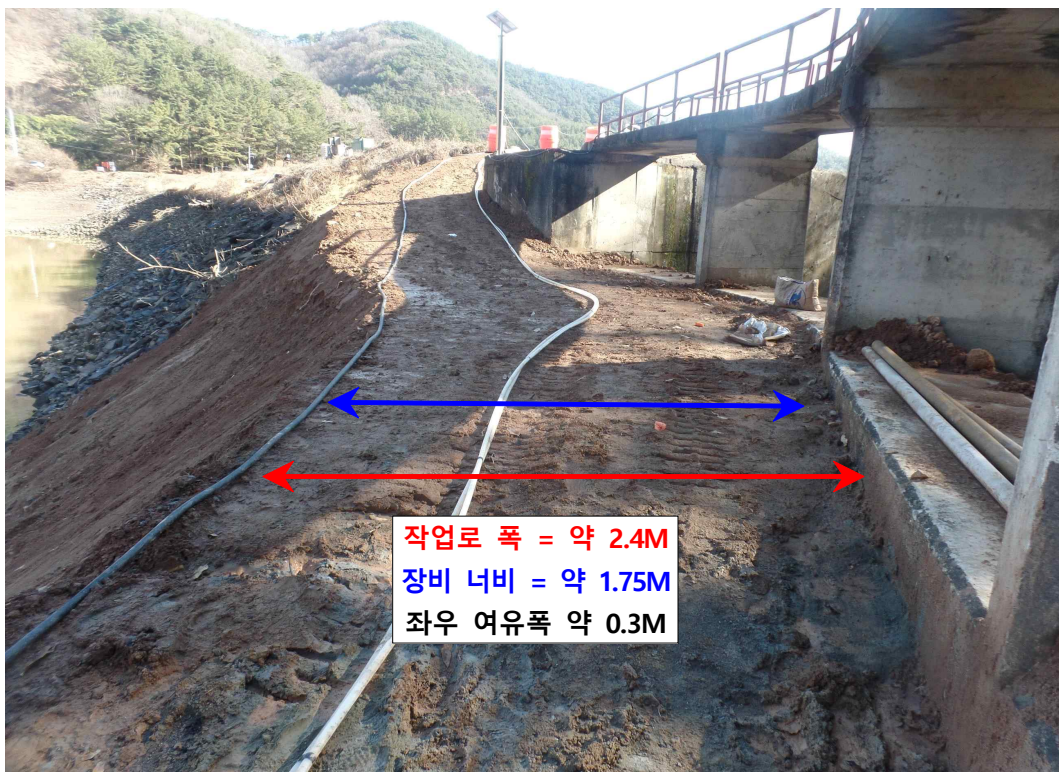
【사진 1】 여수토 제체 그라우팅 작업을 위한 성토부 상단 모습
