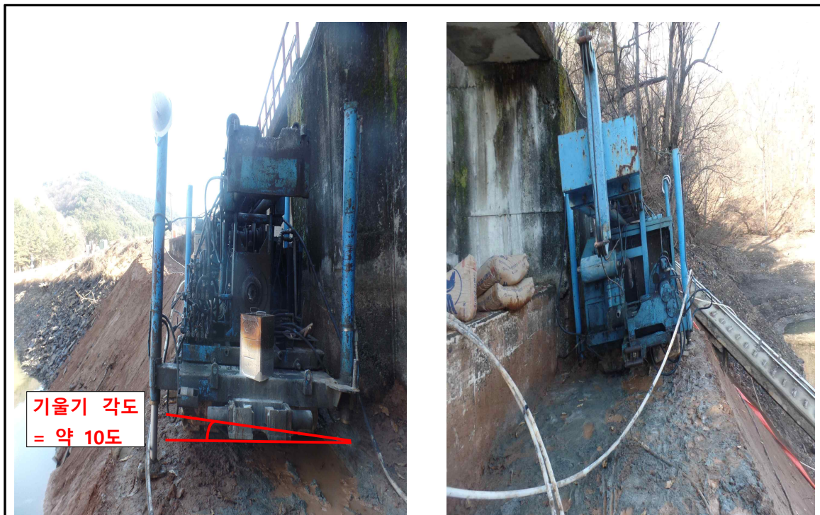
【사진 3】 천공기가 성토구간 위에서 기울어진 모습
