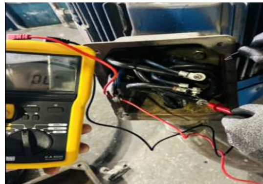
<전선 절연저항 측정>
