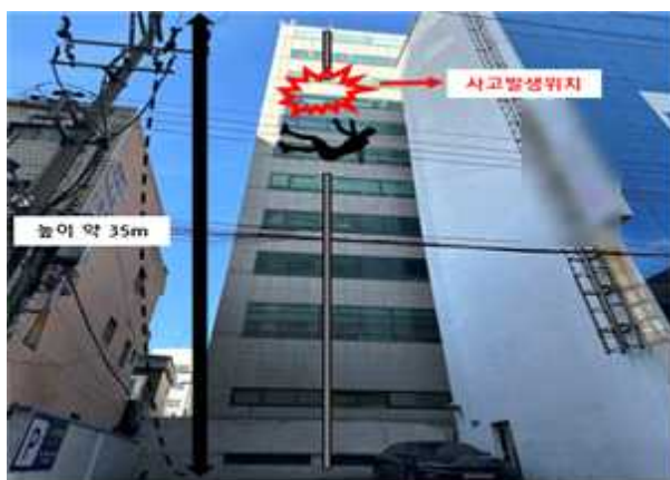
【사진1】 건물 전경 (좌측면)
