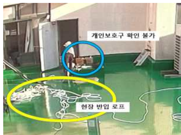
【사진8】 개인보호구 및 로프 현장 비치 사진
