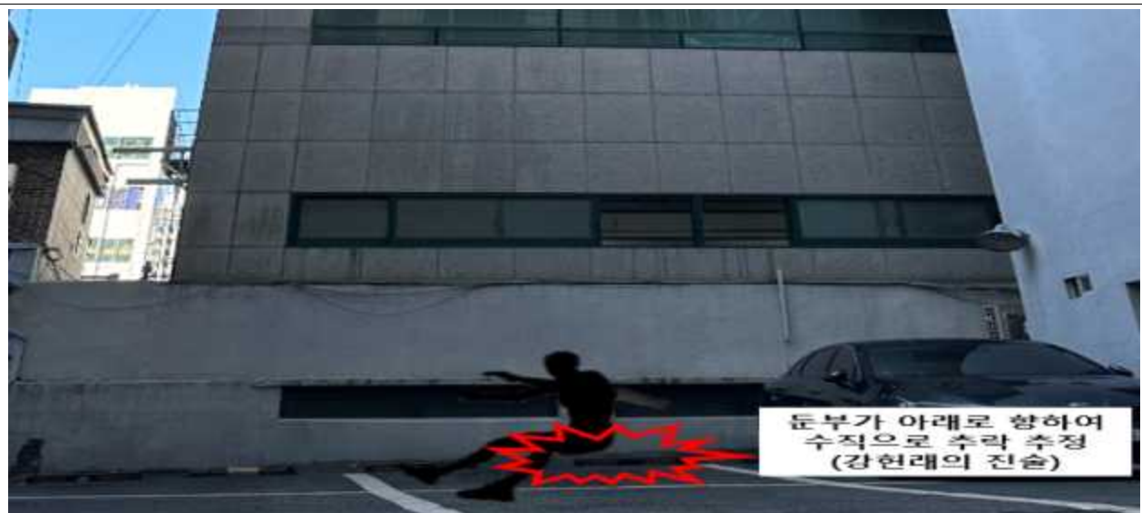
【사진4】 추락 장소 전경
