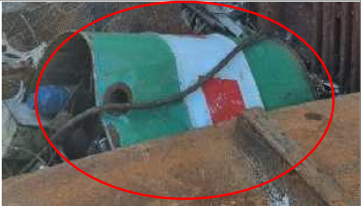
[사진8] 격벽 지지용으로 사용된 고물 담긴 드럼통
