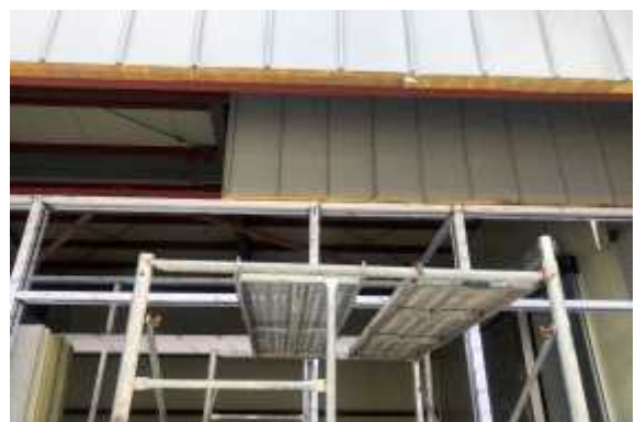
<그림6> 안전난간이 설치되지 않은 이동식비계
