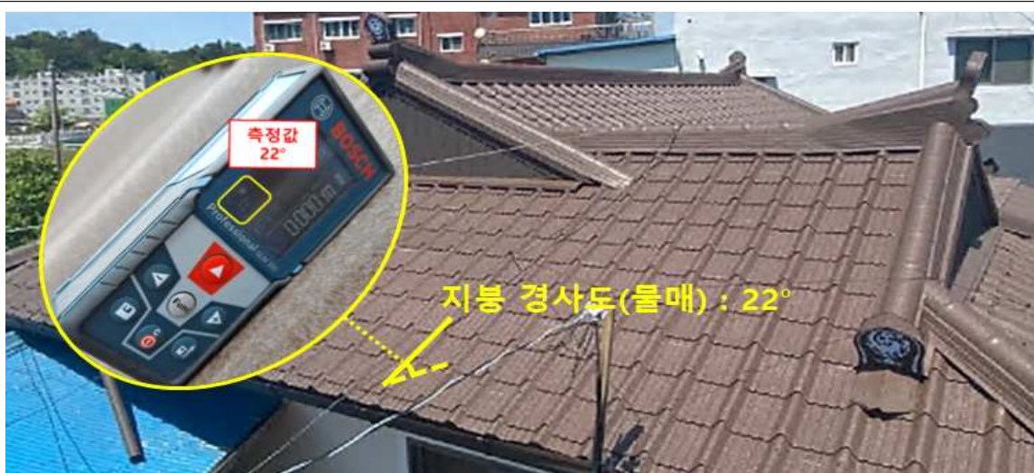
[사진10] 지붕 경사도(물매) 측정
