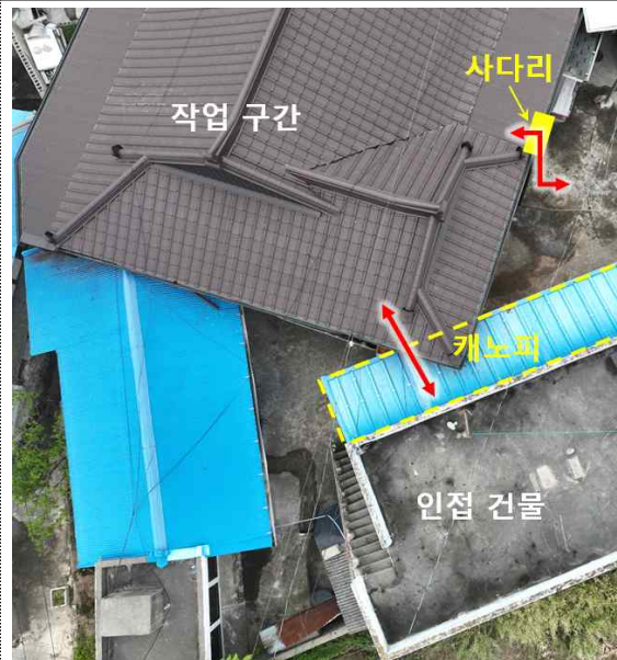
[사진5] 지붕 작업 시 근로자 동선
