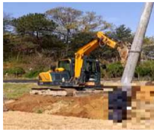
[사진7] 굴착기를 사용한 전신주 세우기 작업 (예시)
