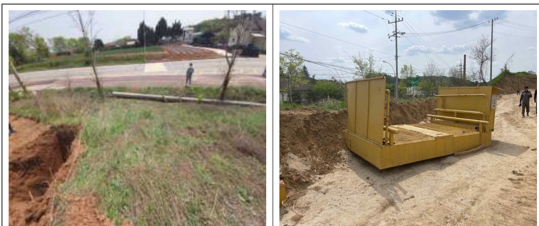
[사진1] 현장 전경
