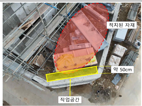
【사진 7】 옹벽 상부②
