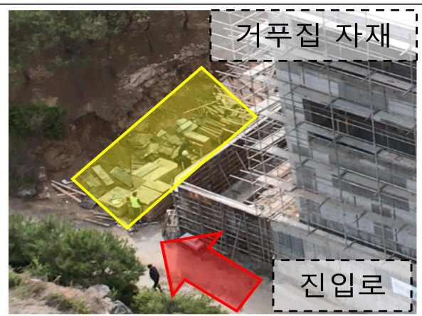
【사진 3】 건물 정면 옹벽 거푸집 해체작업
