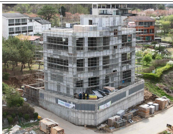
【사진 1】 현장 전경
