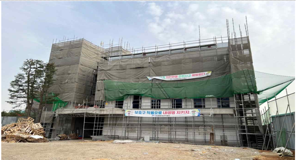
[사진 1] 현장 전경
