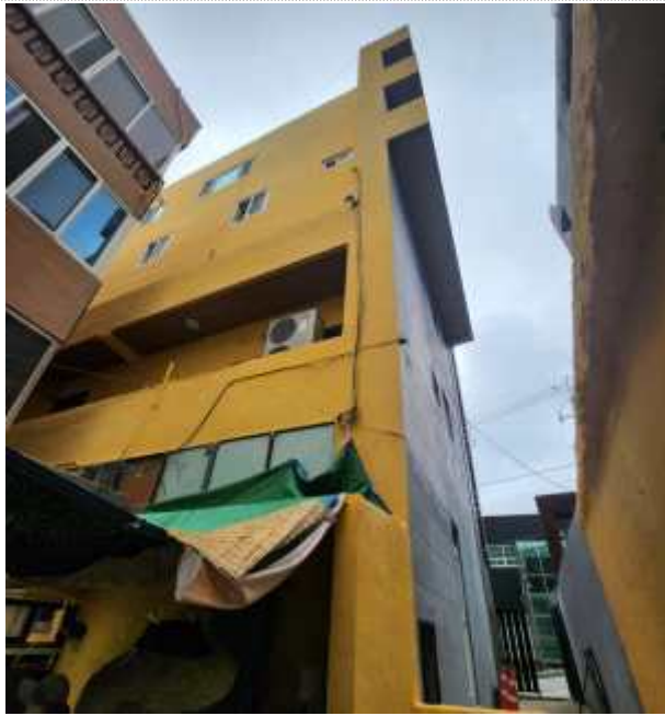
【사진2】 작업 구역(서측 외벽)
