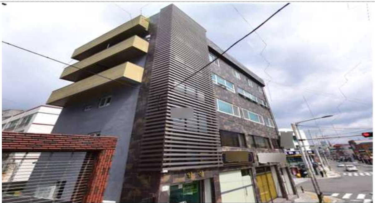
【사진1】 현장 전경(동남쪽)
