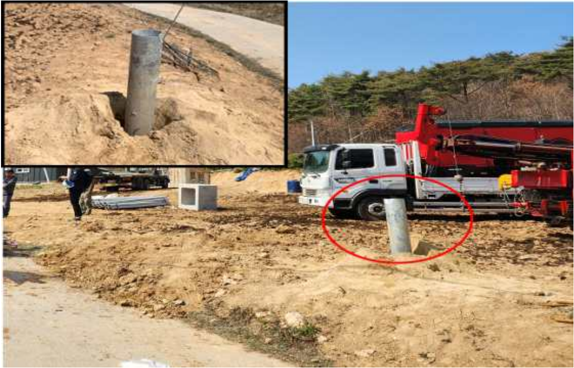
[사진 4] 시추 작업 진행상태 (시추공 1개 설치)
