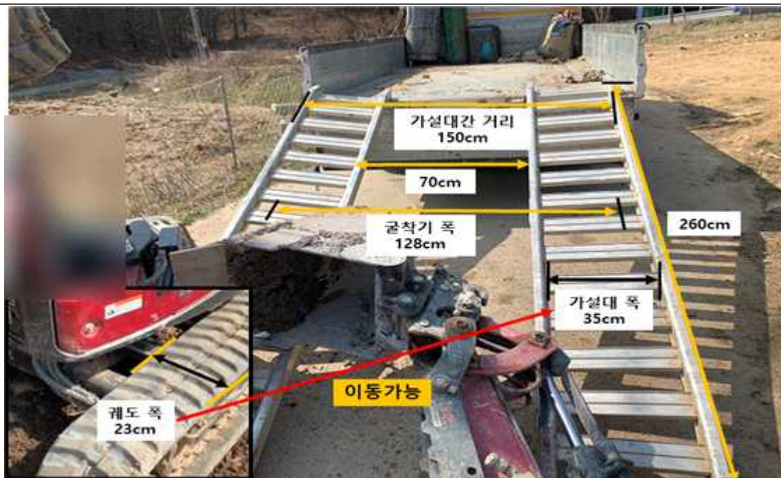
[사진 13] 설치된 가설대 및 굴착기 폭(궤도) 비교
