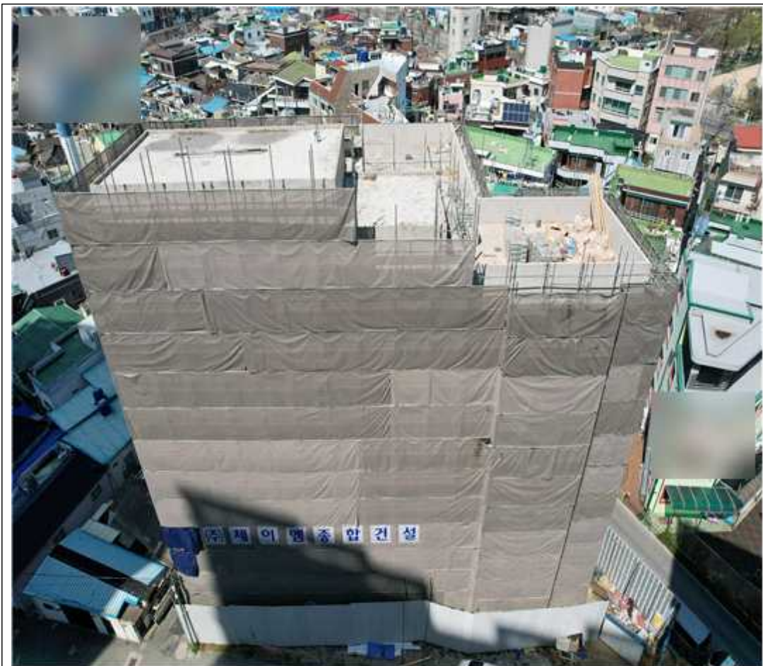
【사진1】 오피스텔 신축공사 전경
