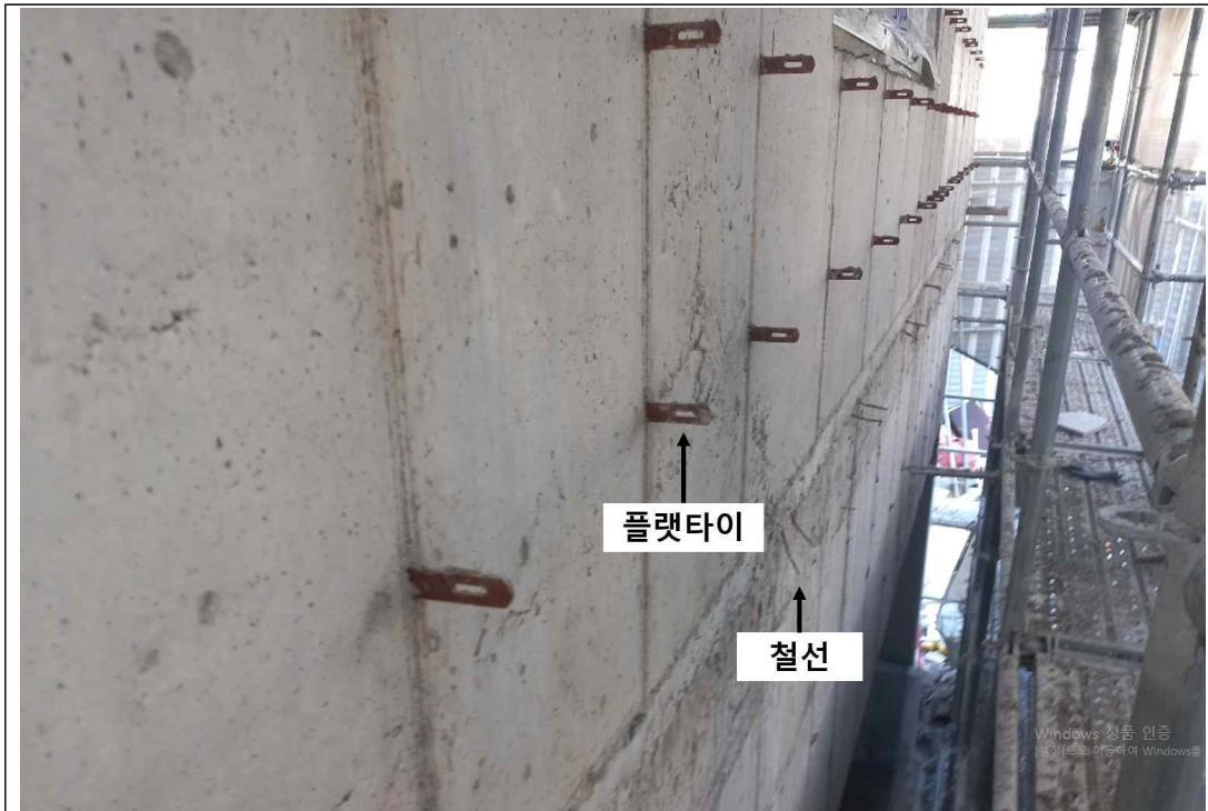
【사진2】 건물 외벽 견출작업 전(거푸집 해체 후 남은 부속철물)
