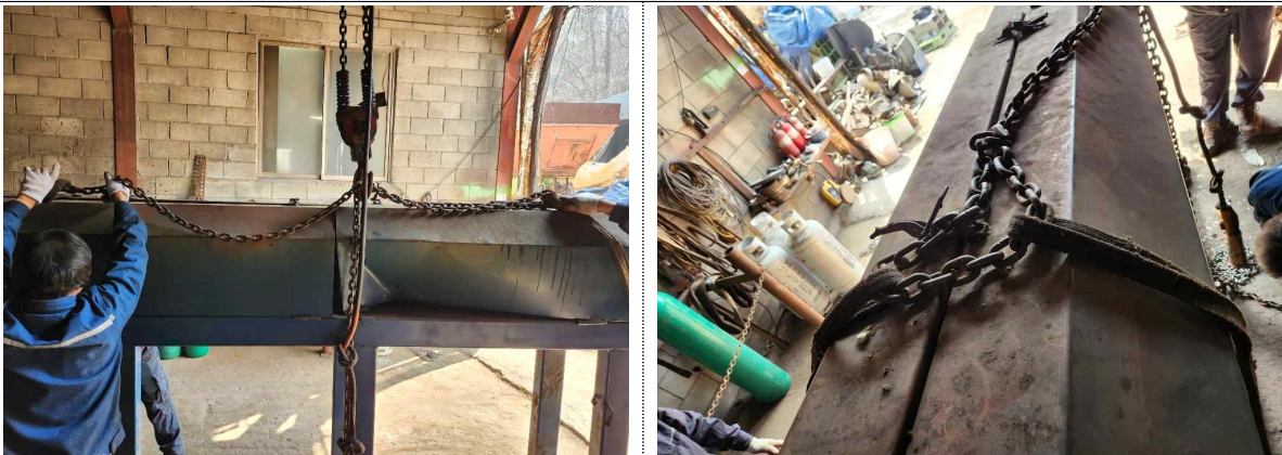
[사진 12] 줄걸이 작업 순서(2)
