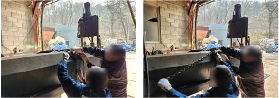
[사진 11] 줄걸이 작업 순서(1)
