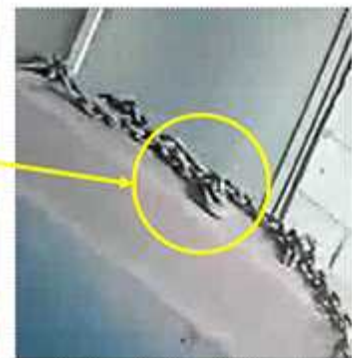
[사진 19] 10시 21 분 20초 경 압출기 천막동 반입 당시 훅 미체결 상태
