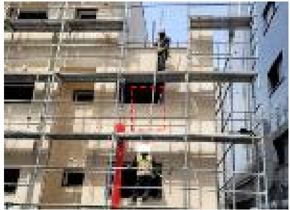
【사진 7】 사고 발생 전 작업 사진
