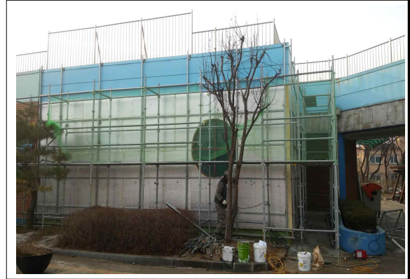
② 단열재 및 하지철물 설치
