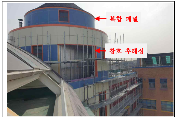
③ 복합패널 설치 및 후레싱 작업
