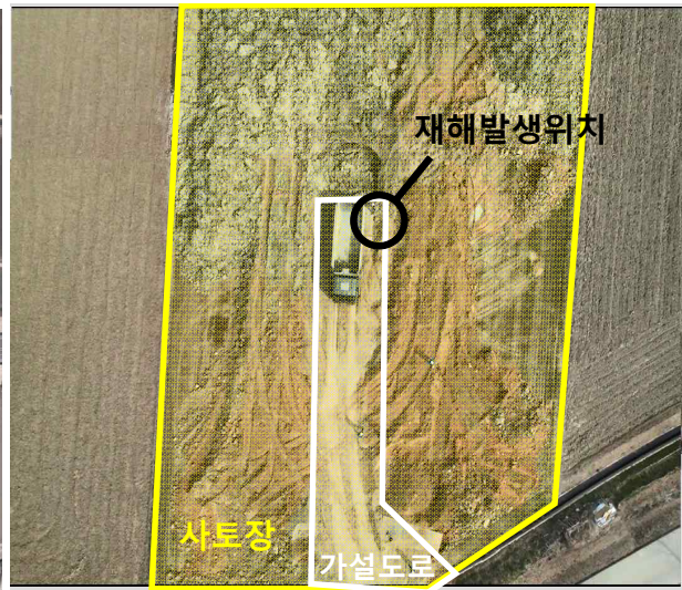
[재해발생 현장 전경(드론 촬영)]
