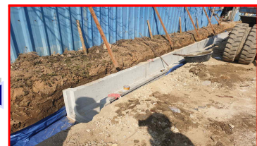
수로관 설치 [재해발생]
