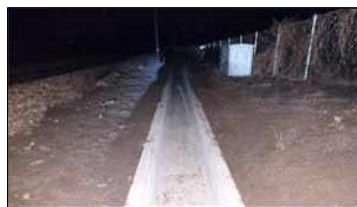
수로관 양측면 되메우기(예시)
