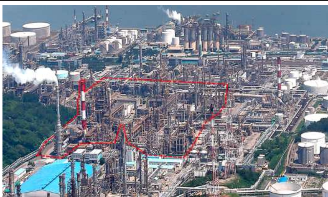
[사진 1] RFCC공정 전경
