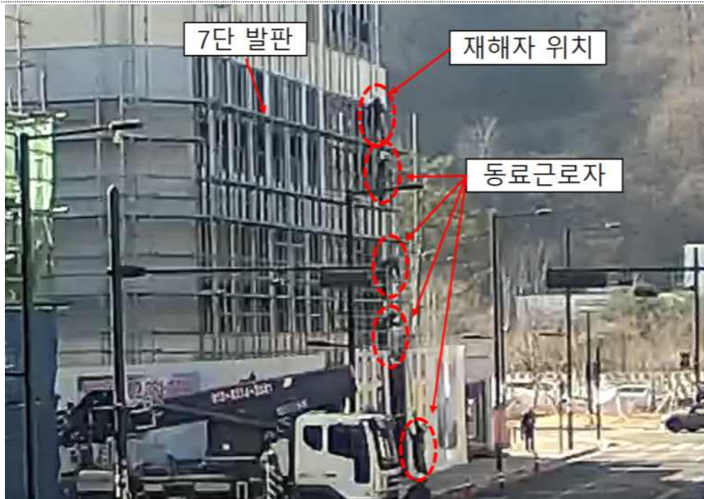
[사진 8] 시스템비계 해체공 배치 상태
