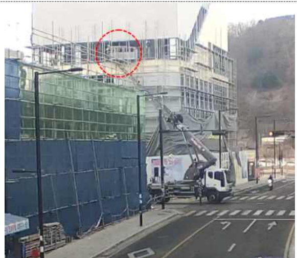
[사진 3] 이동식 고소작업대 작업 현황
