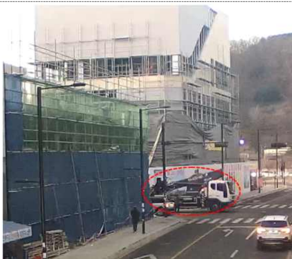
[사진 2] 이동식 고소작업대 위치
