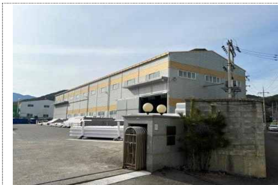
【사진1】 (주)부일테크노 제조동 전경
