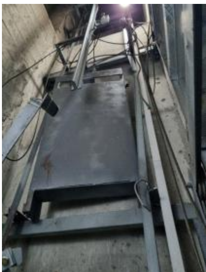
【사진5】 덤웨이터 운반구에 연결된 와이어로프 절단부위
