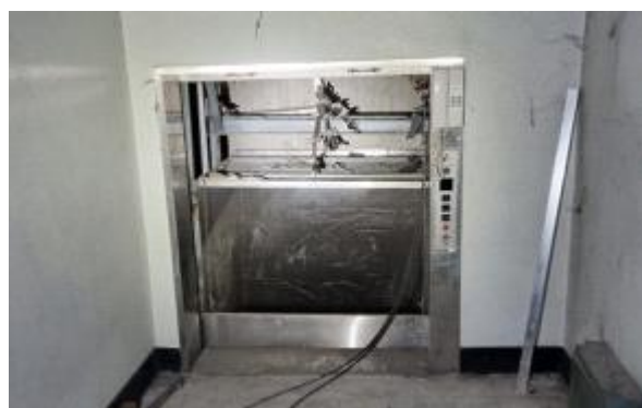
【사진5】 지하1층 덤웨이터 승강장
