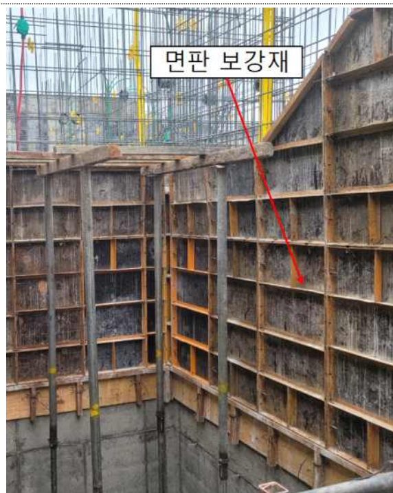
[사진 7] 벽체거푸집 설치 상태
