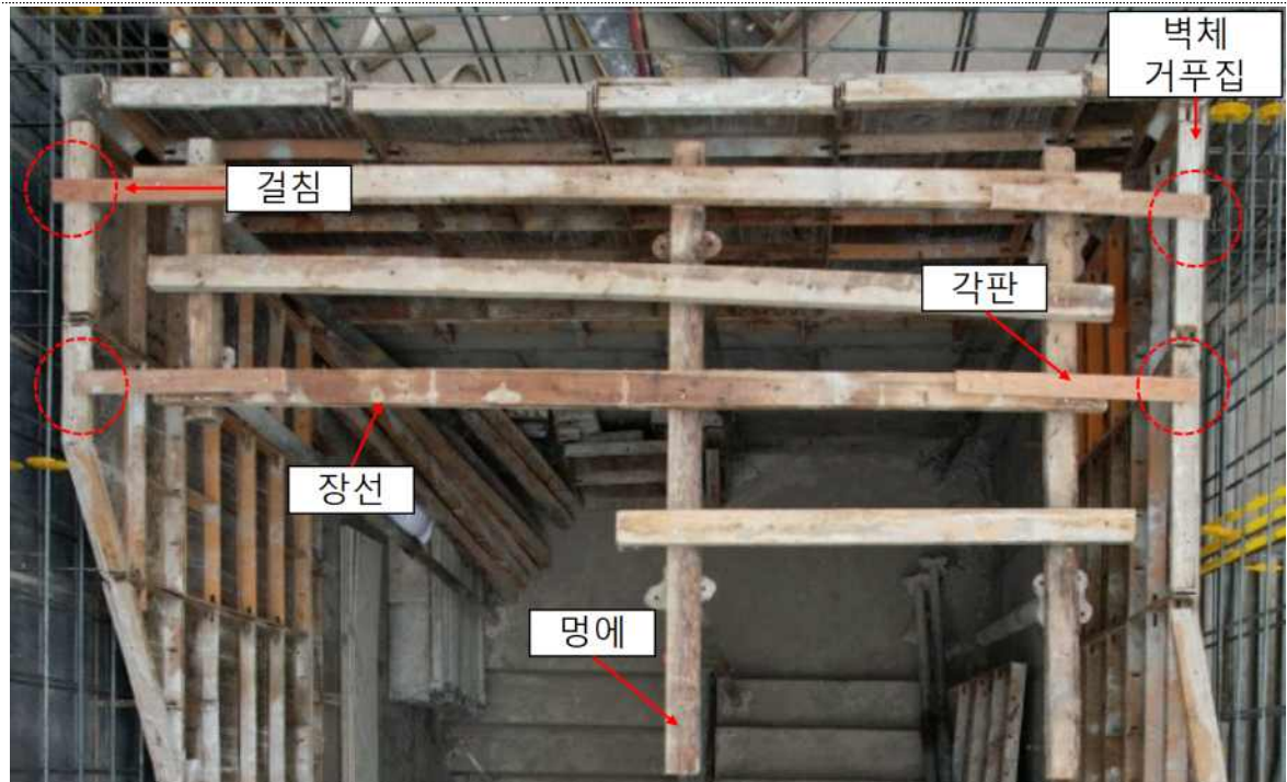
[사진 2] 장선, 멍에의 설치 상세
