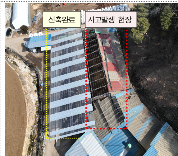
[사진 1] 재해발생 현장 전경(외부)
