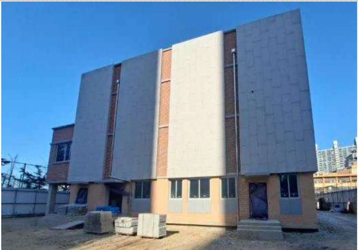
[사진 1] 현장 전경
