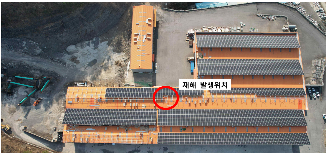
【사진1】 현장 전경
