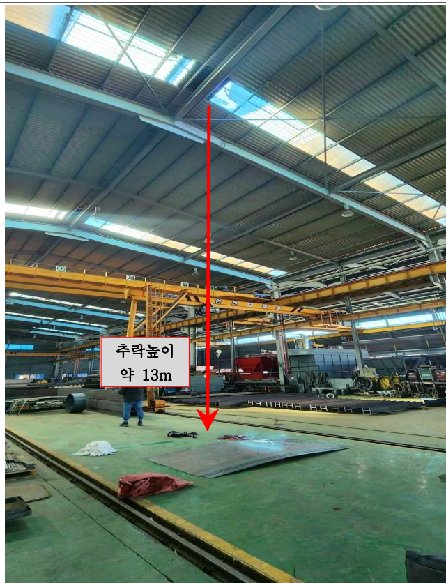
[사진10] 공장 내부 추락지점
