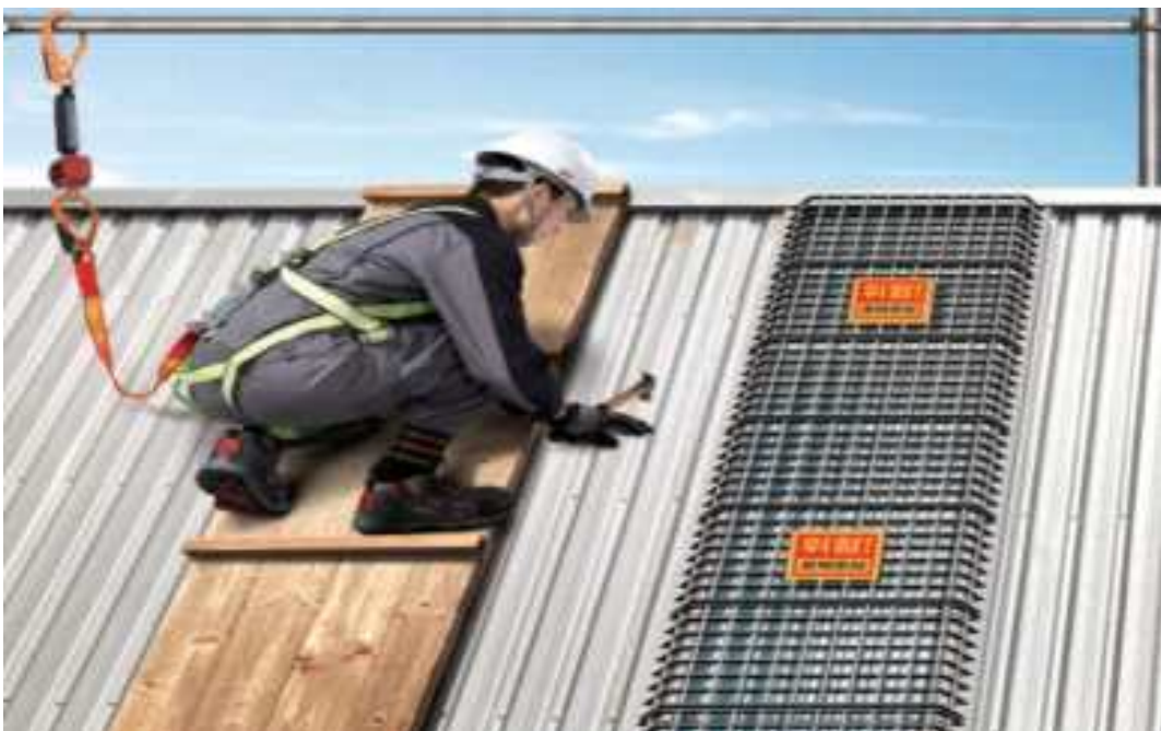
[사진17] 지붕 위 안전작업 예시
