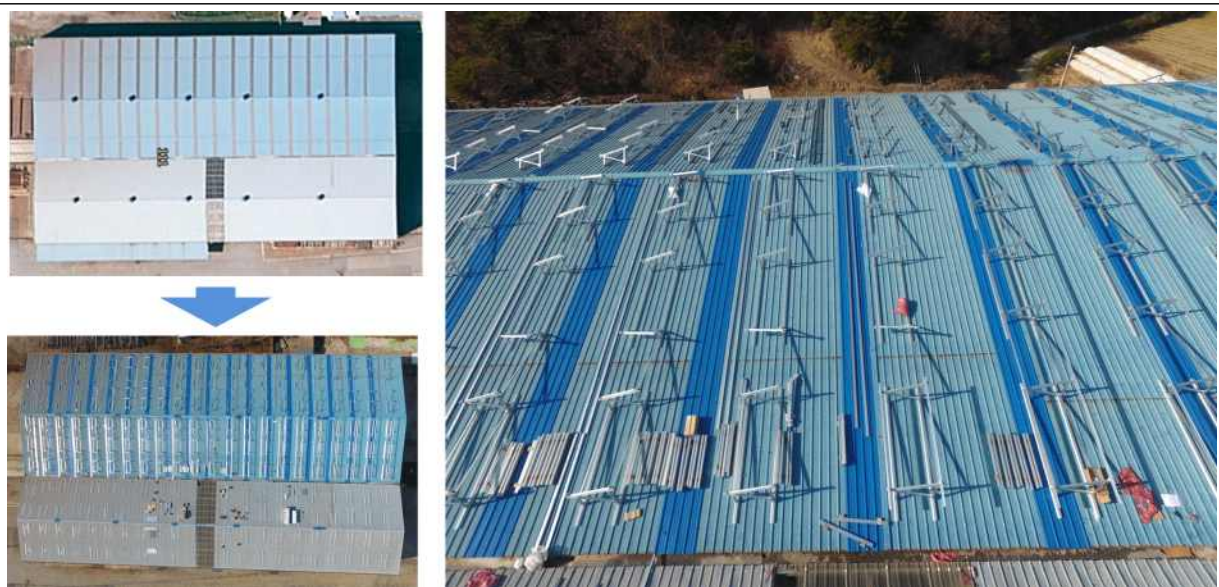
【사진6】 중앙1 지붕 채광창 교체
