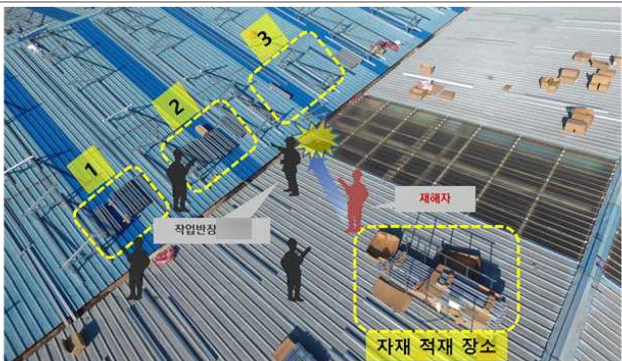
【사진3】 재해발생 당시 설치부 작업 위치
