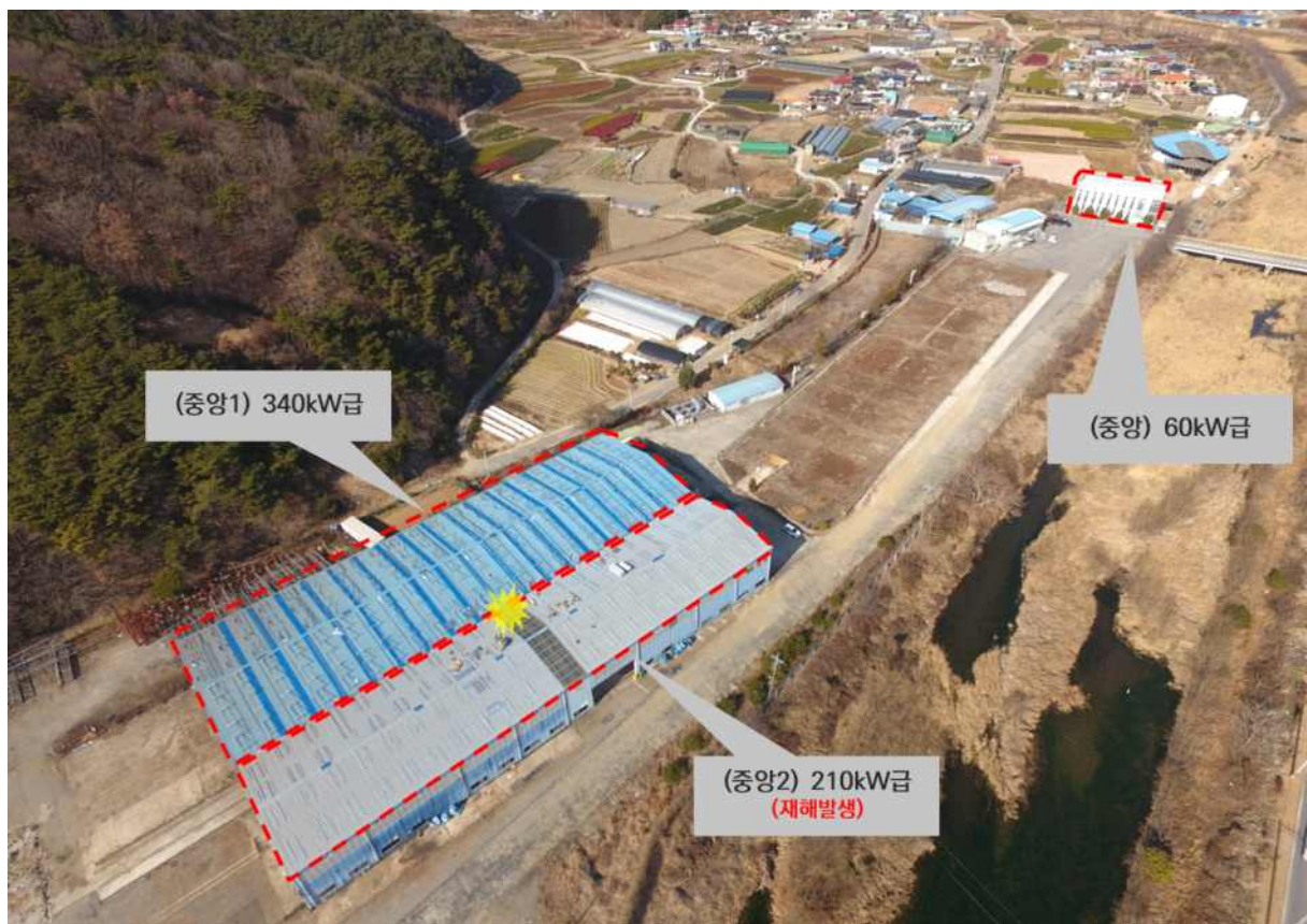
【사진1】 (주)신한이앤지 태양광 발전설비 시공현장 전경
