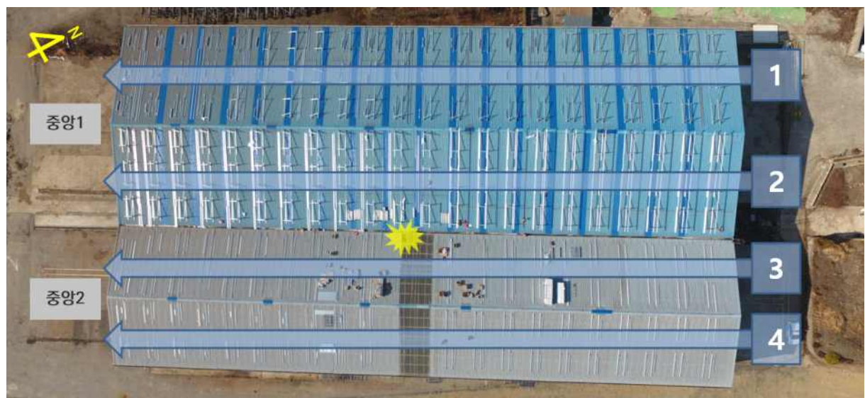
【사진2】 중양1, 중양2 태양광 발전설비 구조물 설치 공정 작업방향
